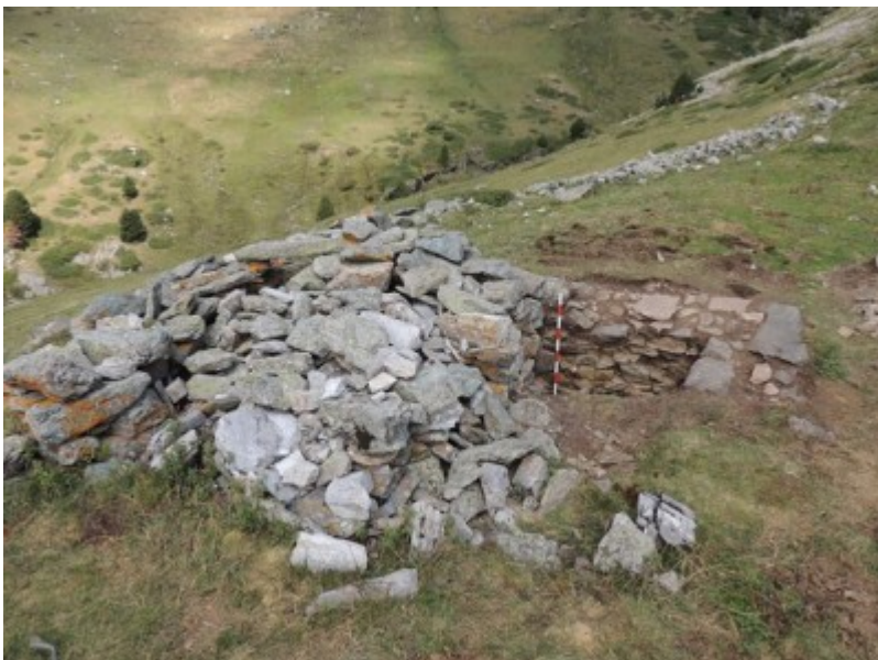
Detall de les dues fases constructives a la gran cabana a Fontnegra.
