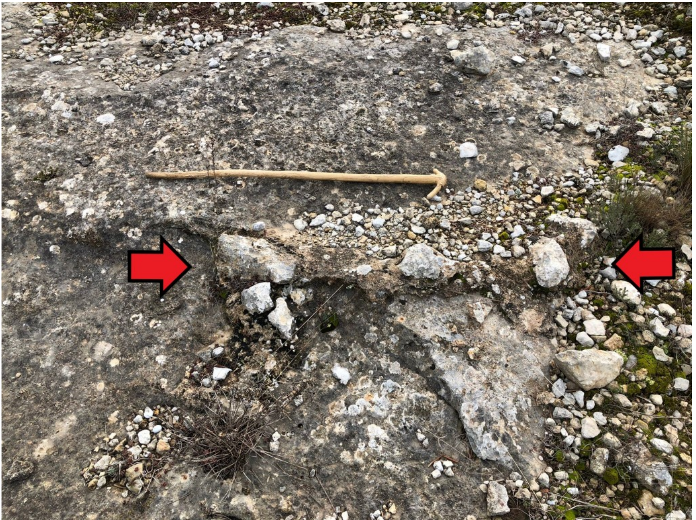
Piedras ligadas con mortero de cal sobre la roca, único resto de los cimientos del acueducto.
