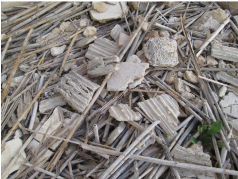
Restos constructivos en una construcció reciente
